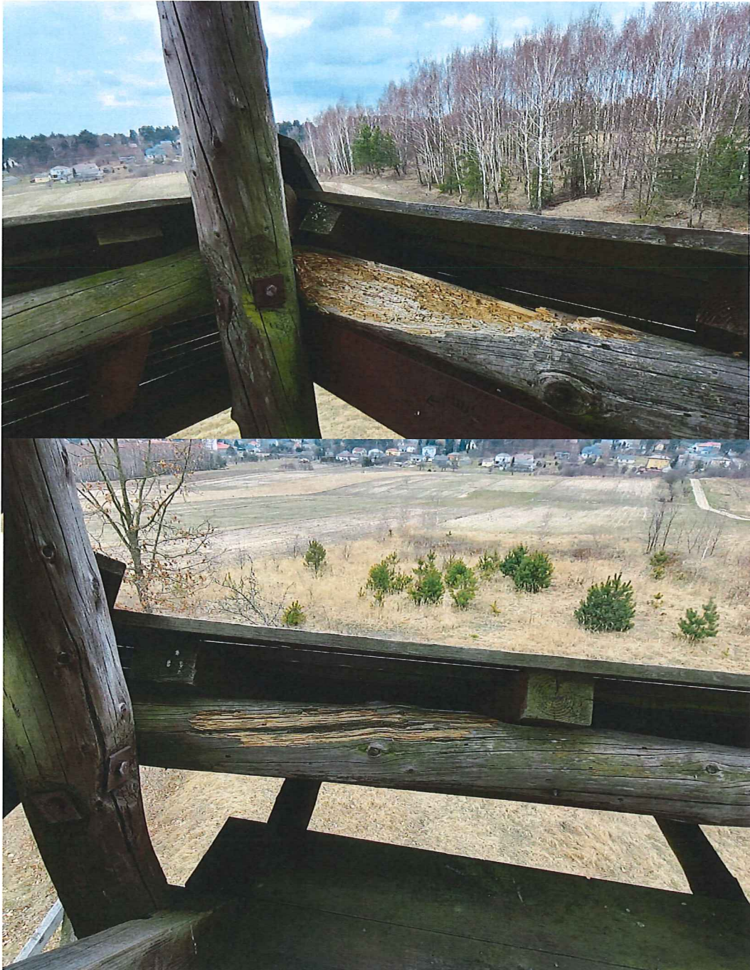
Fot. 8 i 9 – Belki wsporcze daszków na pierwszym podestem
