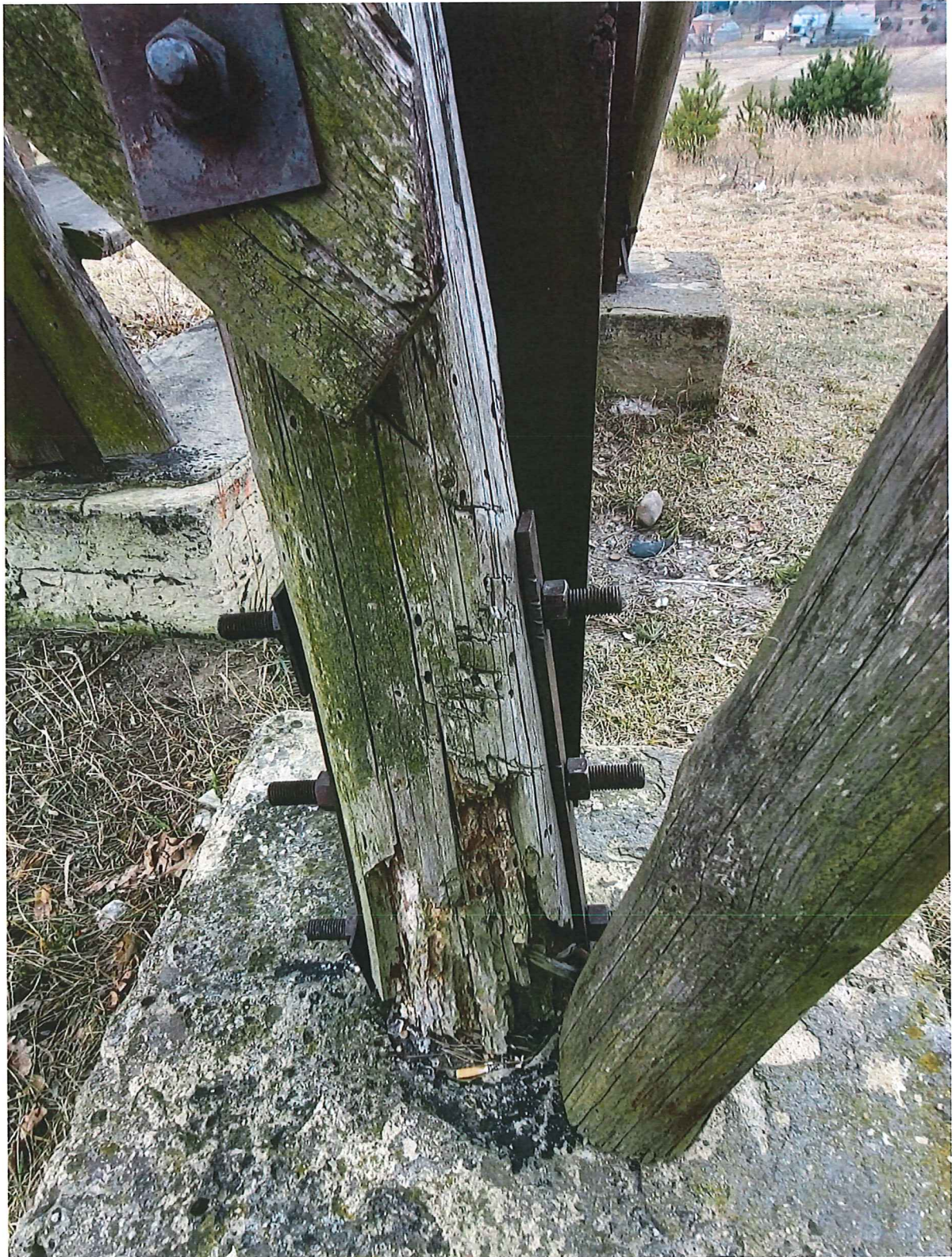
Fot. 4 – Oparcie słupa na stopie betonowej nr 2
