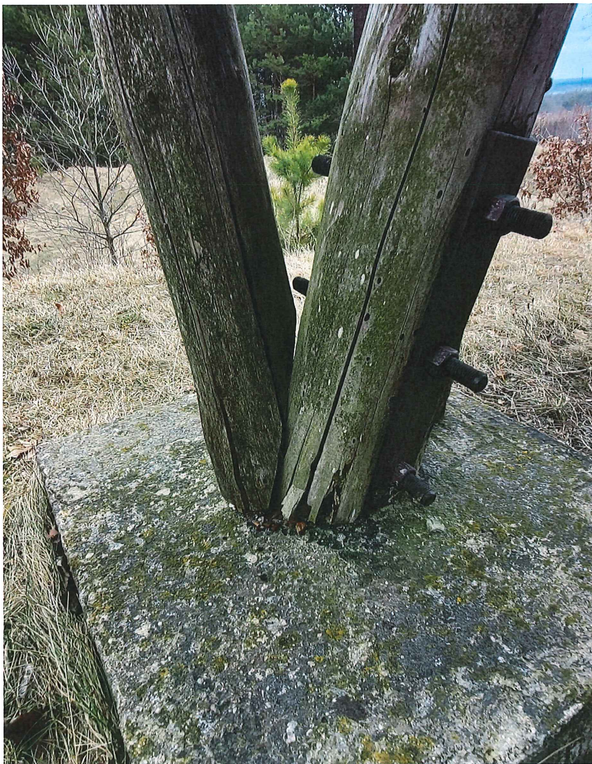
Fot. 3 – Oparcie słupa na stopie betonowej z dołożonym zastrzałem (oparciem) dla pomostu pierwszego poziomu.
