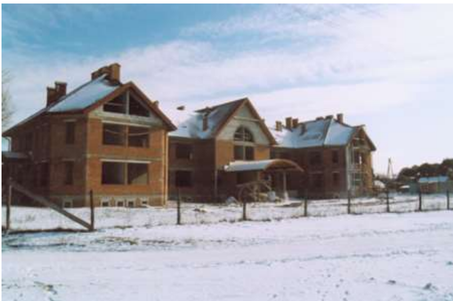
Budynek gimnazjum w trakcie budowy, docelowo postulowane wykorzystanie części budynku na potrzeby konferencyjno – hotelowe.
