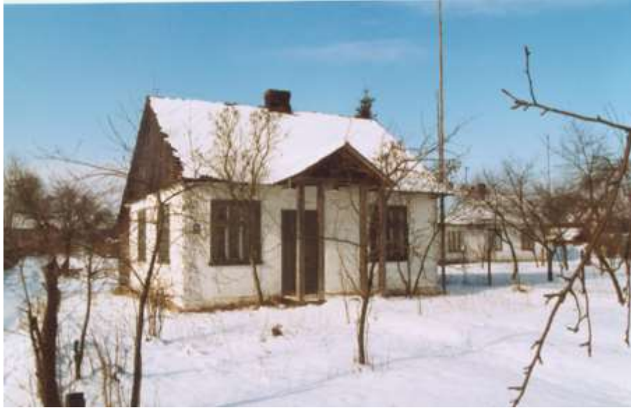
Zabudowa regionalna – budynek drewniany we wsi Bytyń.
